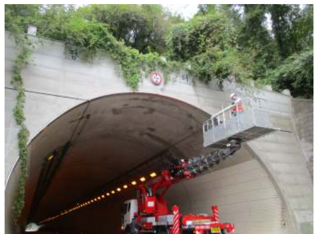
고소차량을 이용한 외관조사
